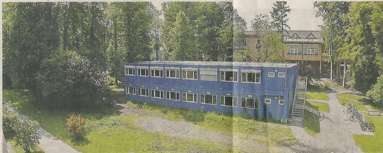
Diese Container im Krankenhauspark lindern die Raumnot, acht weitere sollen nun hinzukommen.
